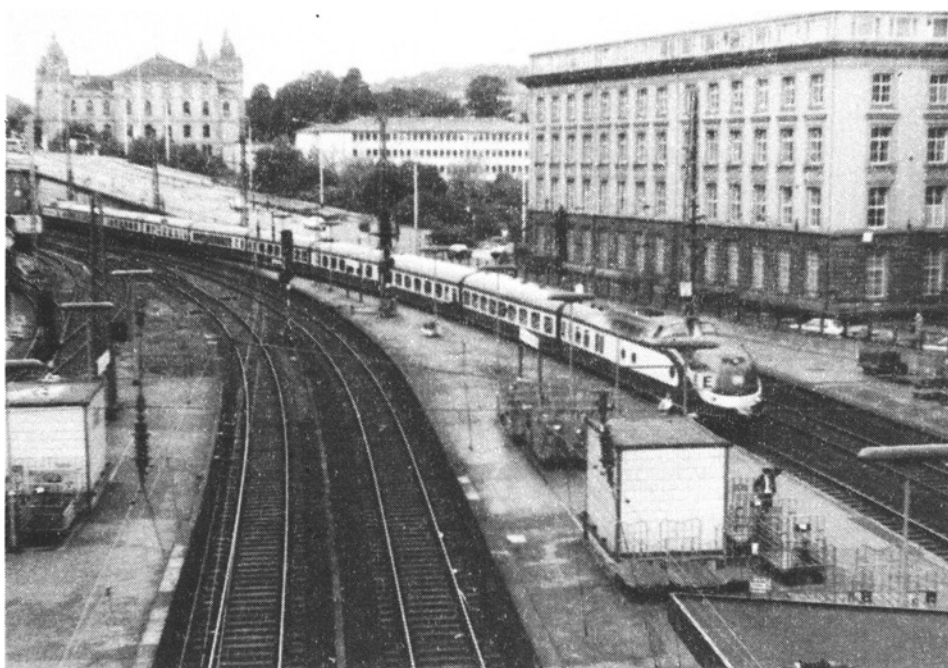
Die moderne Eisenbahn in Wuppertal (Günter Reith)
