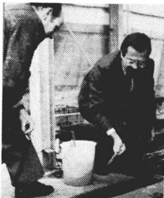
Landtagsabgeordneter Reinhard Grätz legte nachträglich den Grundstein für die Wagenhalle des Vereins in der Kohlfurth. Zur Feier des Tages lud man zur 3,5 Kilometer langen Fahrt ein.
