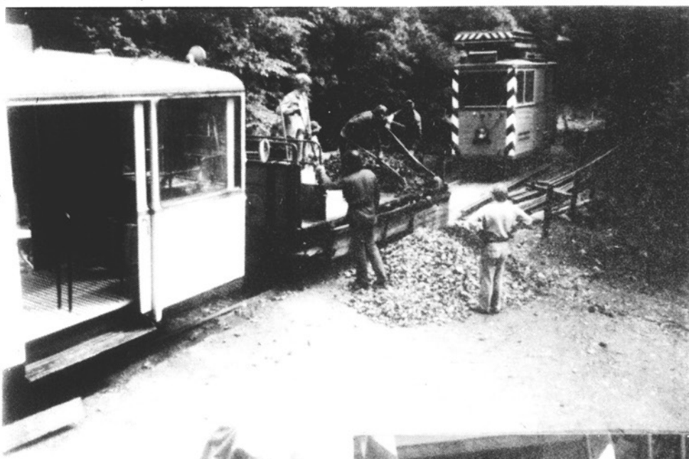
Grossbaustelle am Teich
