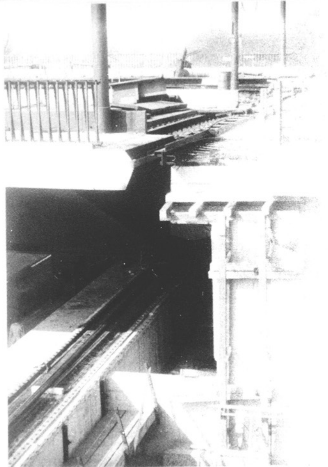
13 Die neue Brücke hat nun ihre endgültige Lage erreicht, Düsseldorfer Seite, 8. April 1976. Blick auf Gleitbahn und Nahtstelle. Foto: R. Jacobi
