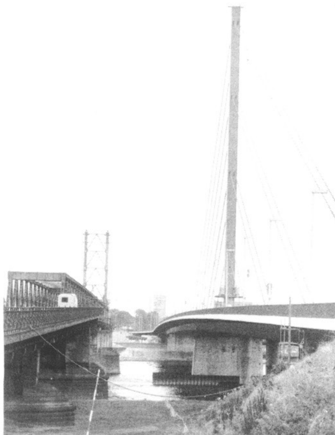
9 Die neuerbaute Oberkasseler Brücke in ihrer prov. Lage neben der Dauerbehelfsbrücke, August 1974 Foto: R. Jacobi
