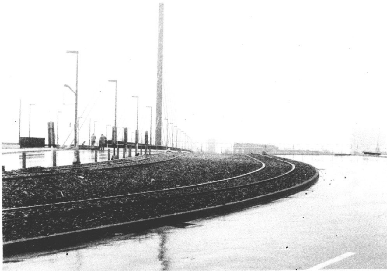
12 Vershub der neuen Brücke von rechts nach links. Die Gleise auf der prov. Oberkasseler Rampe sind bereits ohne Anschluß, 7. April 1976 Foto: R. Jacobi
