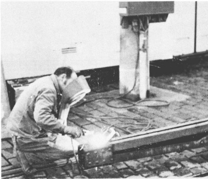
BMB aktuell: Schweißen und Schleifen an einem Oberleitungsmast. 12.11.77.
