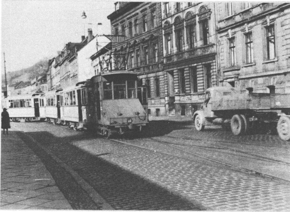
Bild 3 Hier kommt die Rangierlok Nr. 611 mit 3 MAN-Anhängern Nr. 435, 431 und 433 auf die Friedrich-Ebert- Straße. Vor der Lok die doppelte Gleisverbindung.
