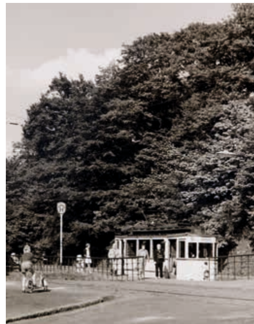
Tw 224 steht im Mai 1959 als Wagen der Linie 14 am Endpunkt Toelleturm. Gut erkennt man die Tieflage des Gleises – Barrierefreiheit anno 1927. Foto: WSW
